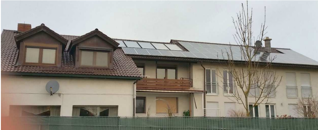
Südansicht des MI-Grundstück im Nordwesten des Bebauungsplangebiets Krummfeld II
